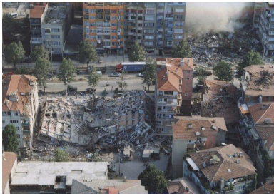
Resim 9, 10, 11. 1999 y,l,nda Marmara depreminde yap,larda meydana gelen tahribatlar.
