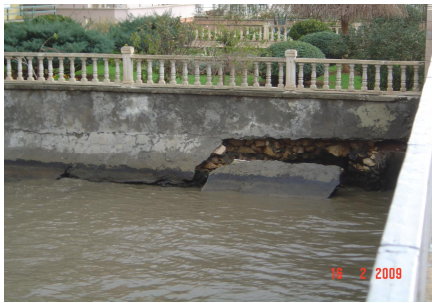
Resim 25, 26, 27. Adana 6 Yumurtal,kta betonda, sülfat ata ,ndan dolay, meydana gelmi tahrifatlar.
