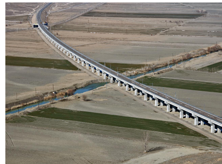
Resim 12, 13. 1999 depreminde Marmara Bölgesinde y,k,lan köprü ile H,zl, Tren Projesi kapsam,nda Ilgaz n aat taraf,ndan yap,lan 2400 metre uzunlu undaki köprü ve viyadü ün mukayesesi.
