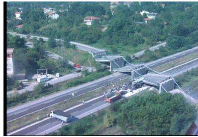
Resim 9, 10, 11. 1999 y,l,nda Marmara depreminde yap,larda meydana gelen tahribatlar.
