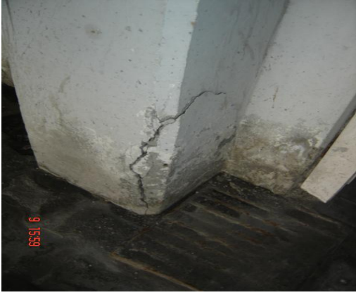
Resim 31, 32. Betonda pas pay,ndan kaynaklanan tahribat.
