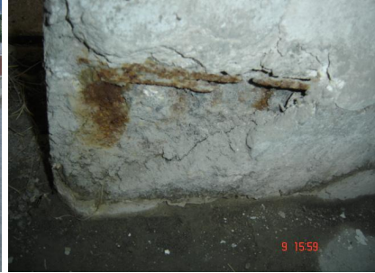
Resim 25, 26, 27. Adana 6 Yumurtal,kta betonda, sülfat ata ,ndan dolay, meydana gelmi tahrifatlar.
