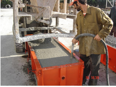
Resim 33. Dalg,ç vibratör ( Ilgaz/Yenice)
