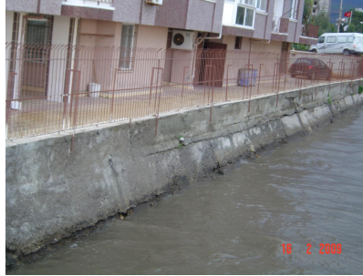
Resim 25, 26, 27. Adana 6 Yumurtal,kta betonda, sülfat ata ,ndan dolay, meydana gelmi tahrifatlar.
