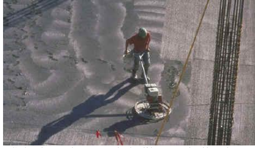
Resim 35. Saha betonlamas,nda helikopter kullan,lmas., ( Ilgaz/Polatl,)
