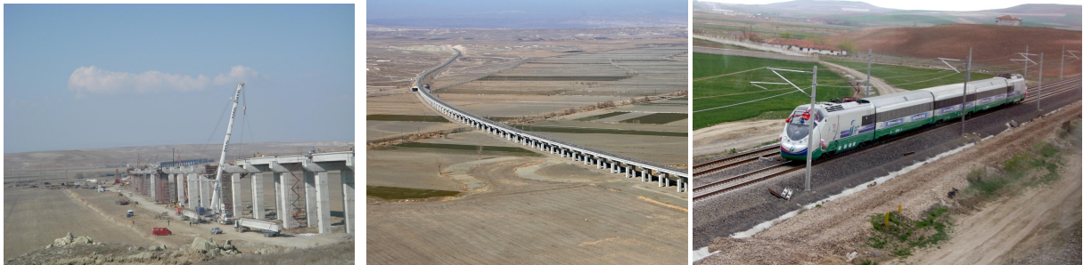
Resim 3,4,5. İlgaz inaat tarafından Ankara- İstanbul Hızlı Tren Projesi kapsamında bulunan 2400 m. uzunluğundaki V4 Viyadükü inaat,
