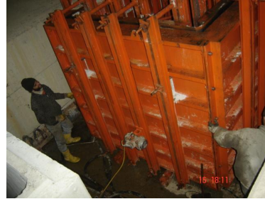
Resim 27. Baks üretiminde sath vibratörü (İlgaz /Polatlı, )
