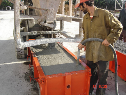
Resim 24. Dalgıç vibratör (İlgaz/Yenice)
