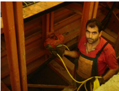
Resim 28, 29. Öngermeli kiriş üretiminde sath vibratörü (İlgaz / Kazakistan Astana )
