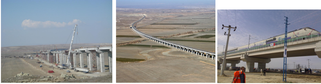
Resim 1, 2, 3. Ankara İstanbul Hızlı Tren Projesi 2400 mt. uzunluğundaki V4 Viyadüğü / İlgaz inşaat 6 2007
