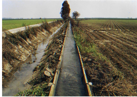
EK L NO 11, 12. Seyhan Baraj gölünden kanalet ebekesine suyun gelişi.
