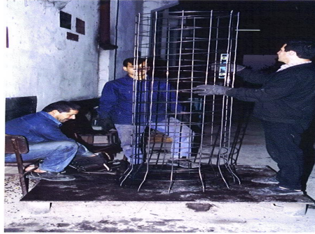
Resim 4. Kafes donatı,da uygunluk kontrolü.
