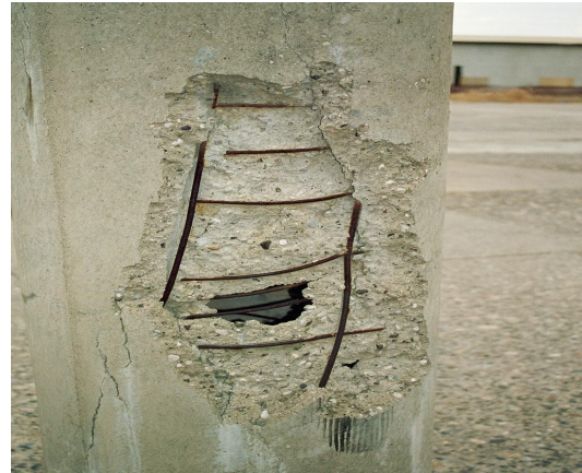
Resim 5,6. Kafes donatısının burulmasından kaynaklanan üretim fireleri.
