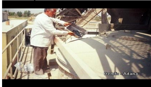
Resim 5. Çelik lifin mikserine boşaltılması.
