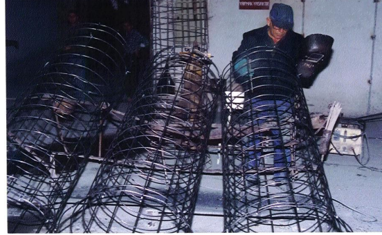
Resim 3. Anbuatman kısmı,ın yapılması.
