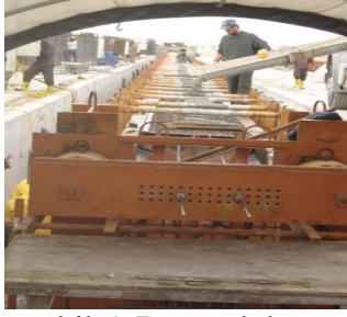
ekil 5. Beton dökümü.
