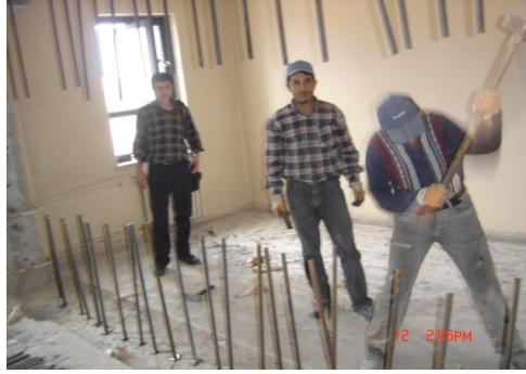
ekil 4. Demir filizin delik içerisine çak, lmas, .
