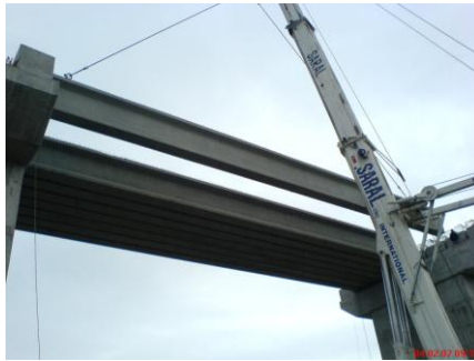
Şekil 3 ve 4. Öngermeli kirişlerin montajı
