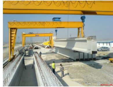
Şekil 1 ve 2. Öngermeli prekast kiriş üretimi
