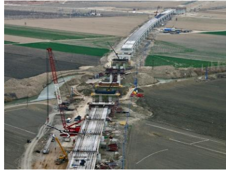
Şekil 3 ve 4. Öngermeli kirişlerin montajı
